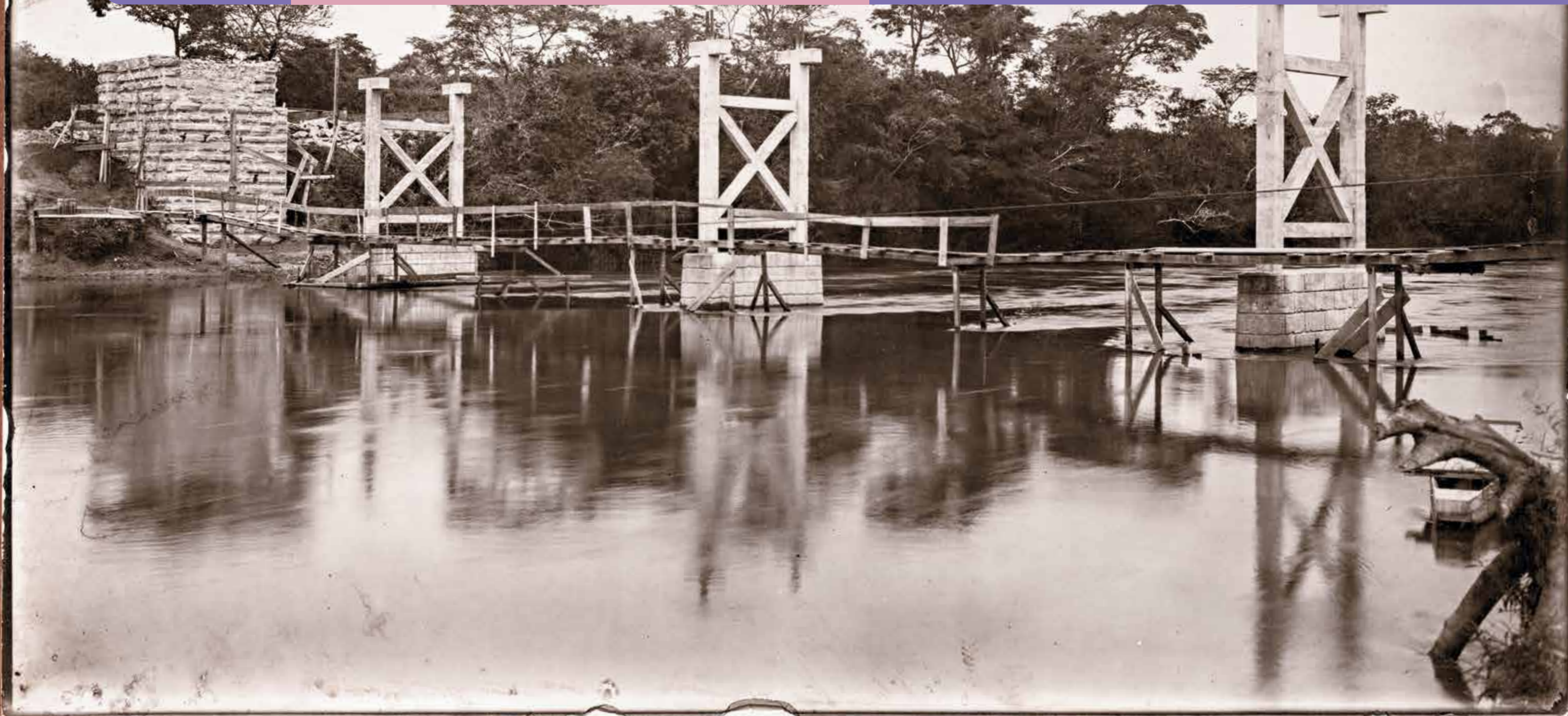
PONTE SOBRE O RIO VERDE EM TRES CORAÇÕES, em construção
